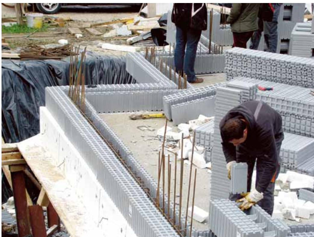
Slika 2 Gradnja nič energijske hiše
